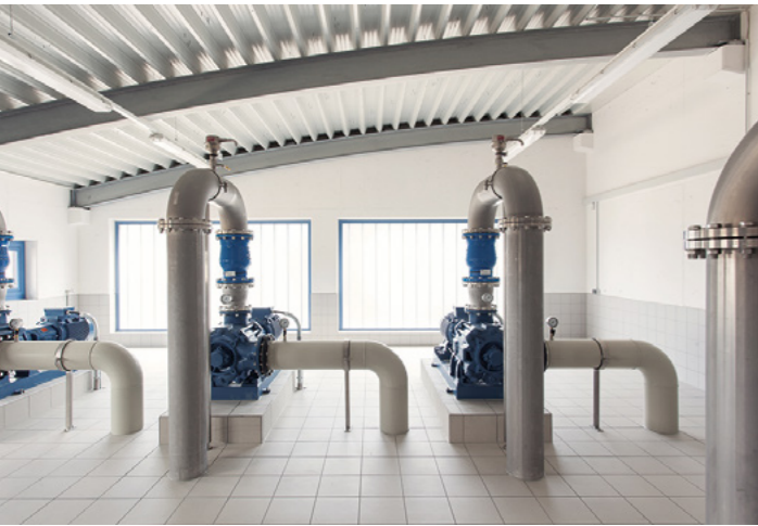
Förderpumpen im Wasserwerk St. Leon-Rot
