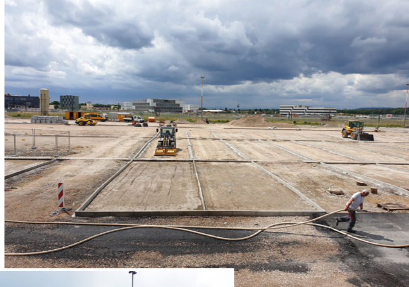
Die Fahrgassen zu den Parkplätzen erhielten eine Asphaltdecke ...
