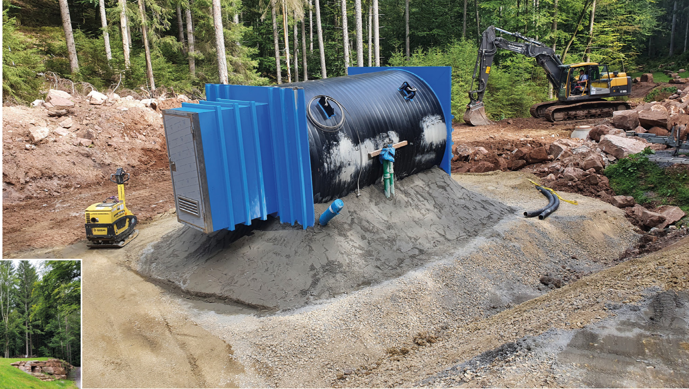
Errichtung des Quellsammlers an der Unteren Tröstbachquelle
