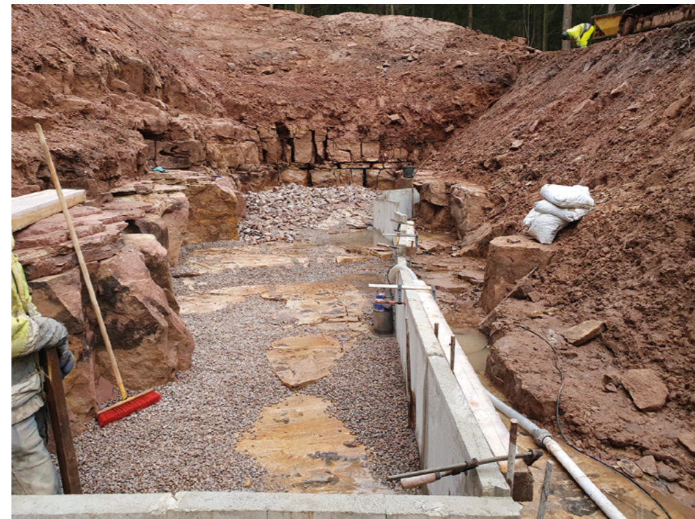
Errichtung des Quellsammlers an der Unteren Tröstbachquelle
