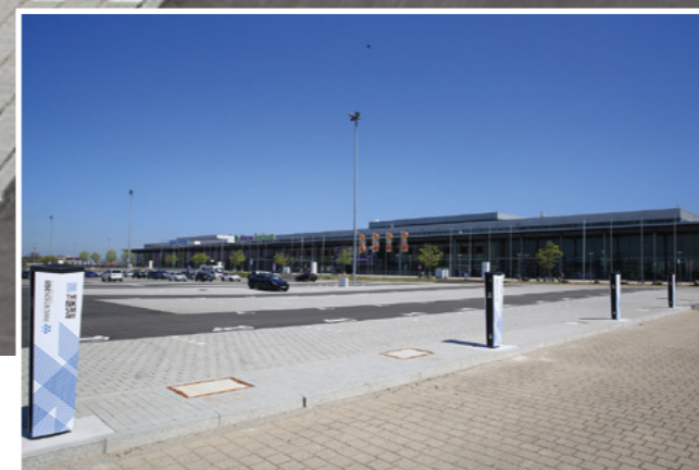
Zur besseren Entwässerung wurden die Plätze „wellenartig“ angelegt (oben).
