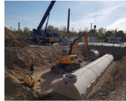
28 Einbau einer Versickerungsrigole
